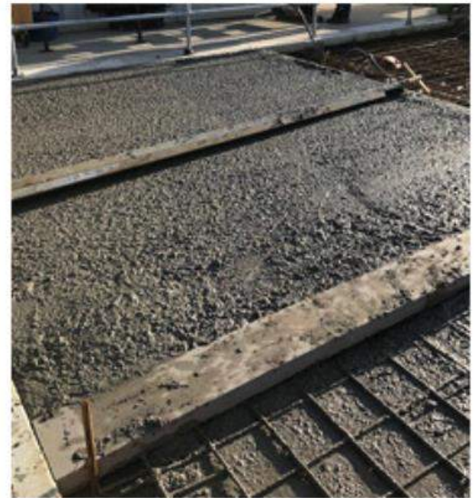
Earth Friendly Concrete pour
